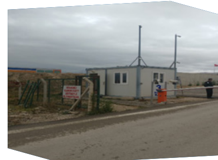
3 No'lu Kapı Yenileme Çalışmaları
