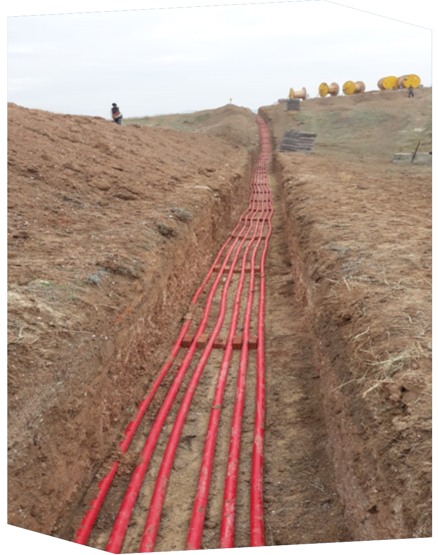
Enerji Nakil Hattı Kablosu Montaj İşlemi
