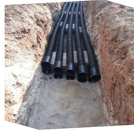
Enerji Nakil Hattı Borulama Çalışmaları
