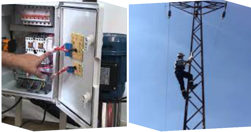
Kuyular Bölgesi Elektrik Şebekesi Bakım Onarım Çalışması
