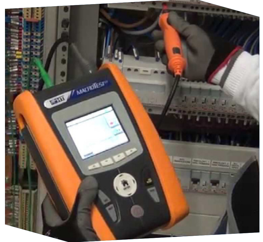
Trafo Merkezlerindeki Topraklama Test Çalışmaları
