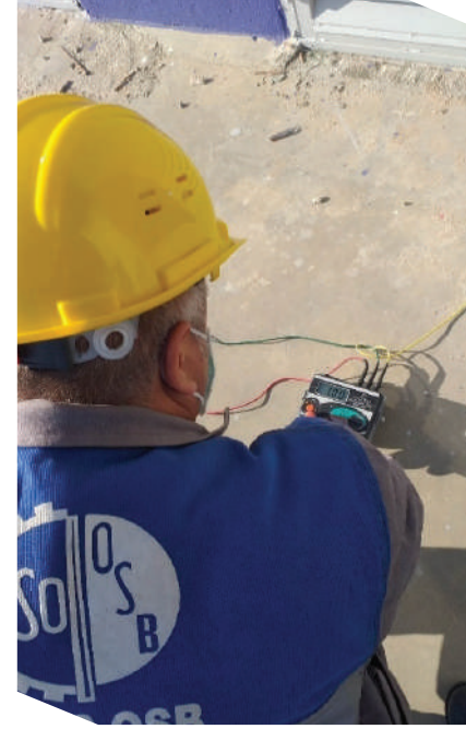
Trafo Topraklama Test Ölçümü
