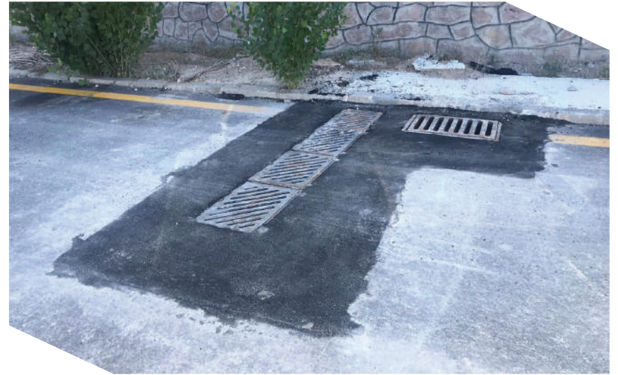
Rögar ve Izgaraların Asfalt Kotuna Getirilmesi
