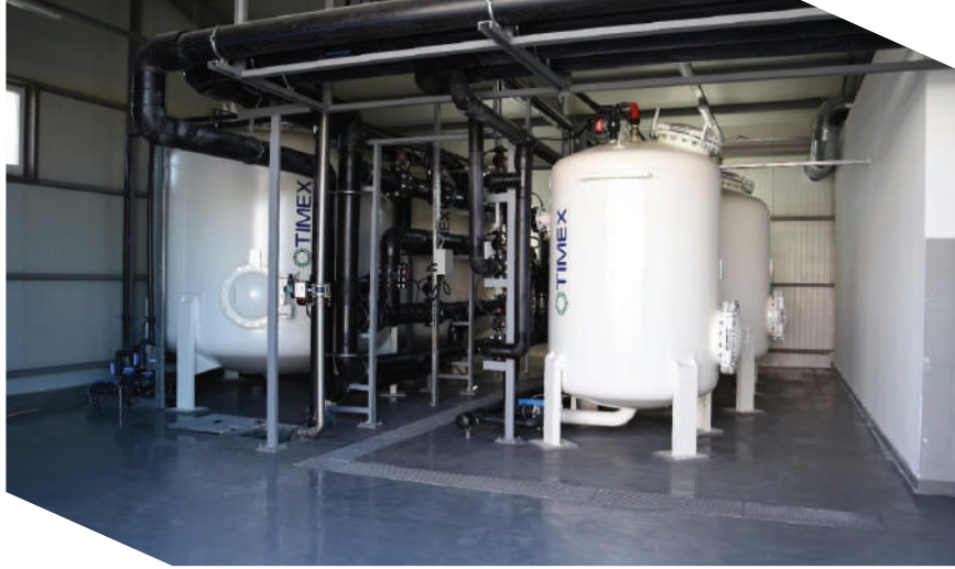
Su Arıtma Tesisi Yumuşatma Ünitesi(Yeni)
