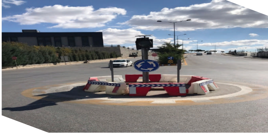
Kavşak Eski Durumu
