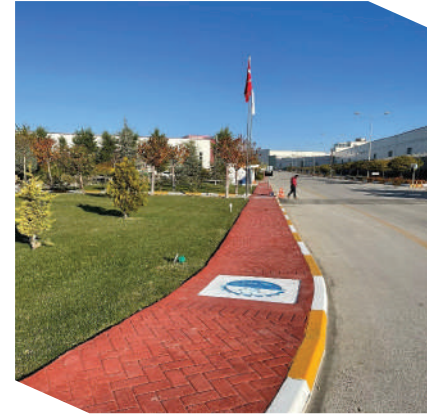
Renkli Baskılı Kaldırım Asfalt Yapımı
