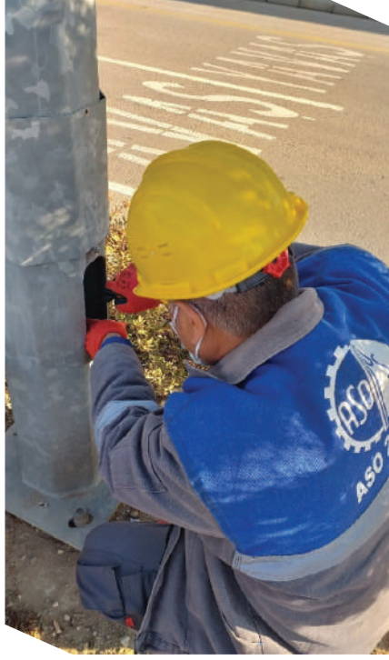
Aydınlatma Direkleri Bakım Onarımı
