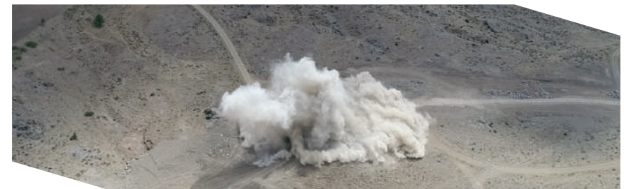
İlave Alan Yol Yapımı Kapsamında Patlatma
