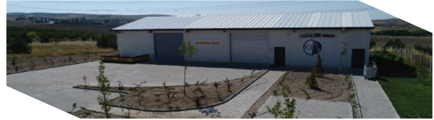
Su Arıtma Tesisi Bina Dış Görünümü
