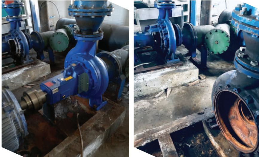
Pompaların Bakım Öncesi ve Sonrası
