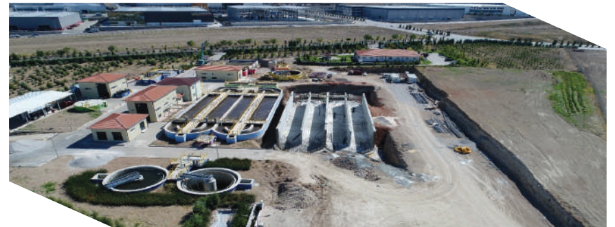
Atıksu Arıtma Tesisi Tevsii Yatırımı İnşaatı
