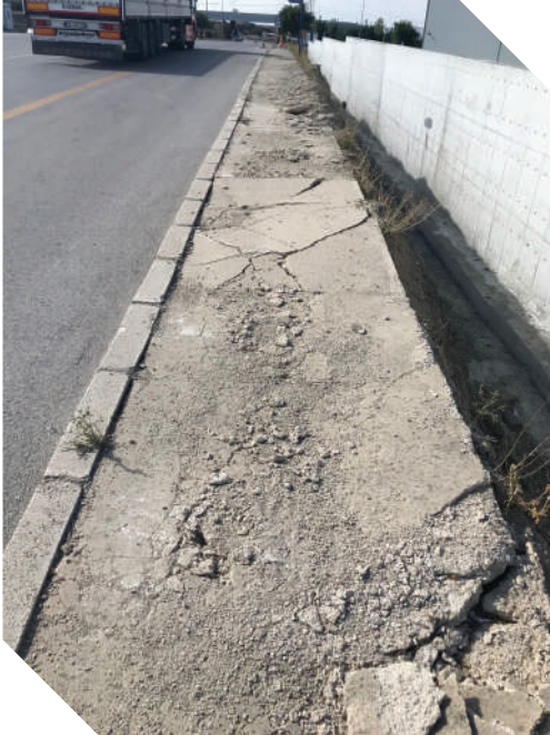
Asfaltlama Öncesi Kaldırım Durumu
