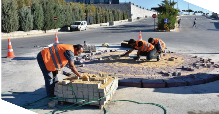
Kavşak Yapım Çalışmaları
