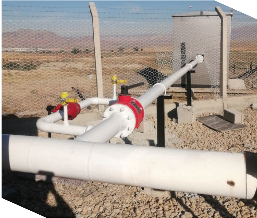
RS-B Doğalgaz İstasyonu Ek Yapımı
