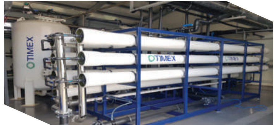
Su Arıtma Tesisi Ters Ozmoz Ünitesi (Yeni)
