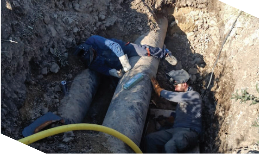
Çelik Boru Tamir ve Kaynağı
