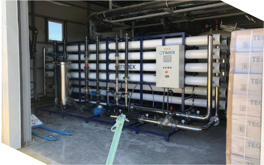
Ters Osmoz Ünitesi (Yeni)
