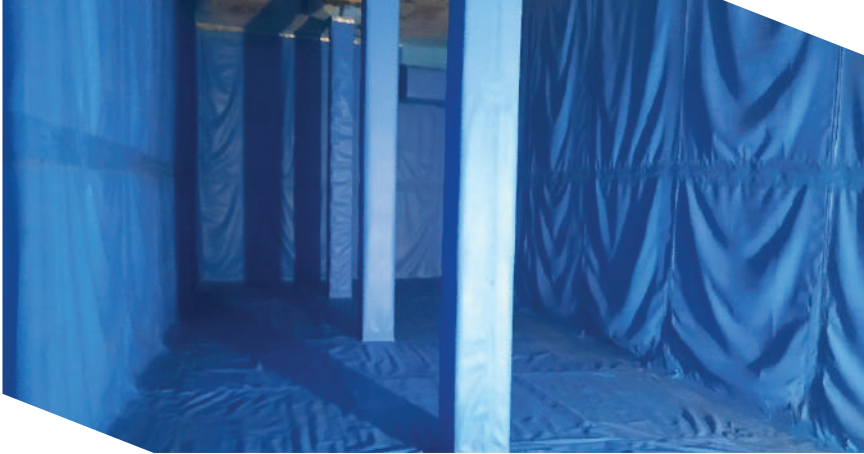
Su Depoları Yalıtım İşleminin Görüntü
