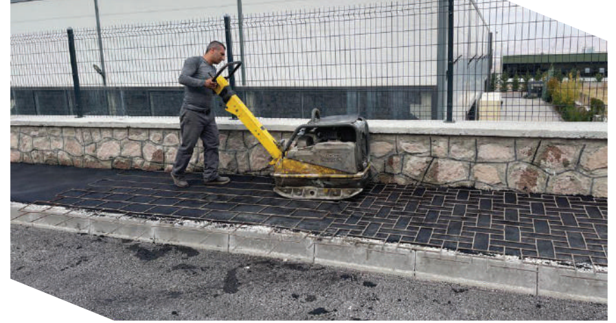
Kaldırım Asfalt Yapımı
