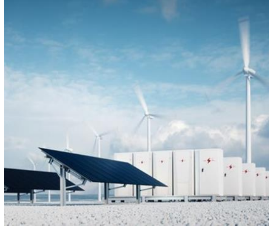
Enerji Depolama Çözümleri
