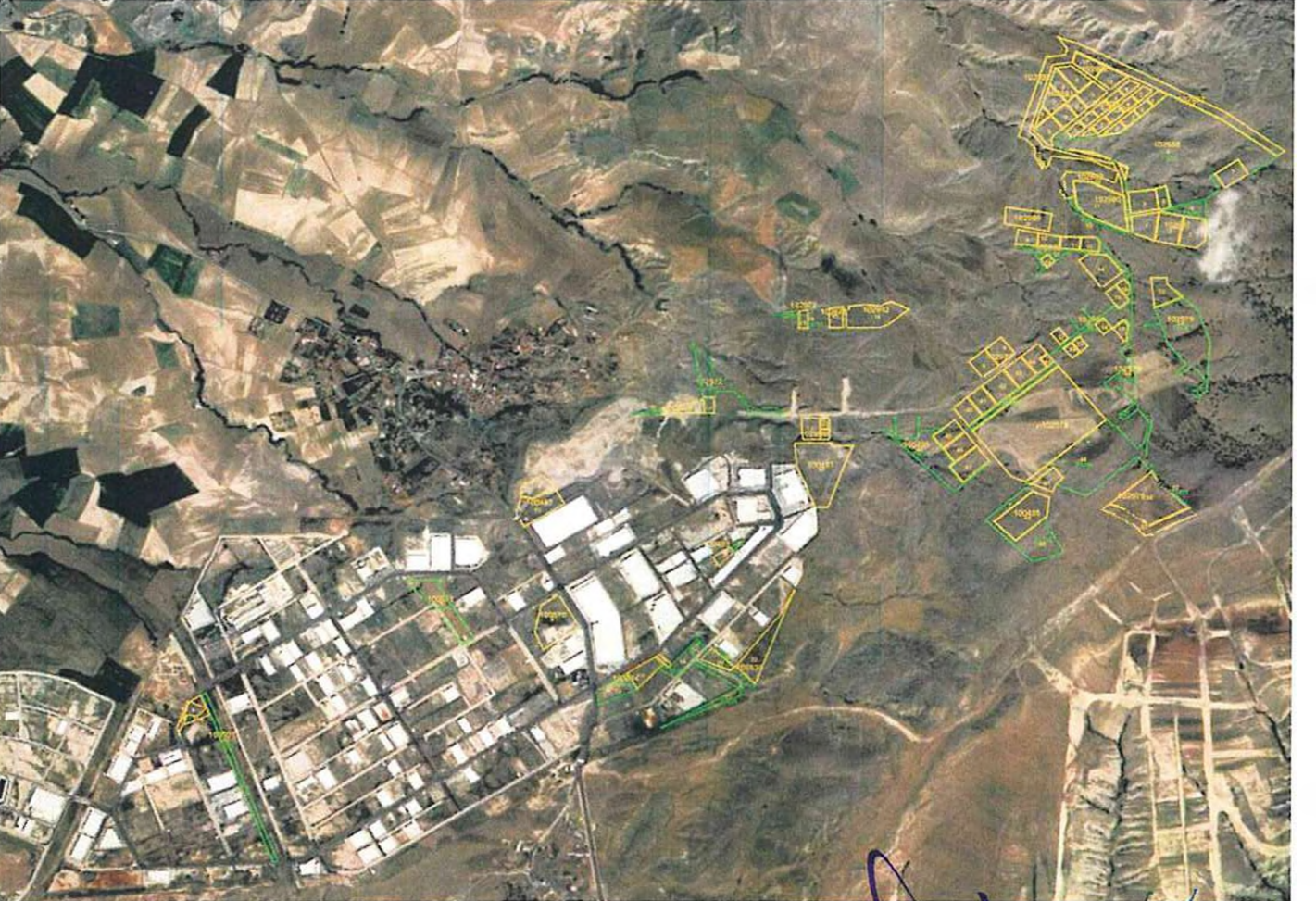
- Uygulama Sonrası Oluşan Durumun Görüntüsü
